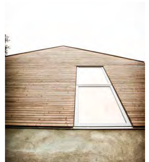
Betontøbt base og listebeklædning i varmebehandlet gran
