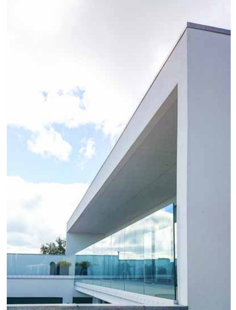
Glasværn langs hele østfacadens overdækkede terrasse
