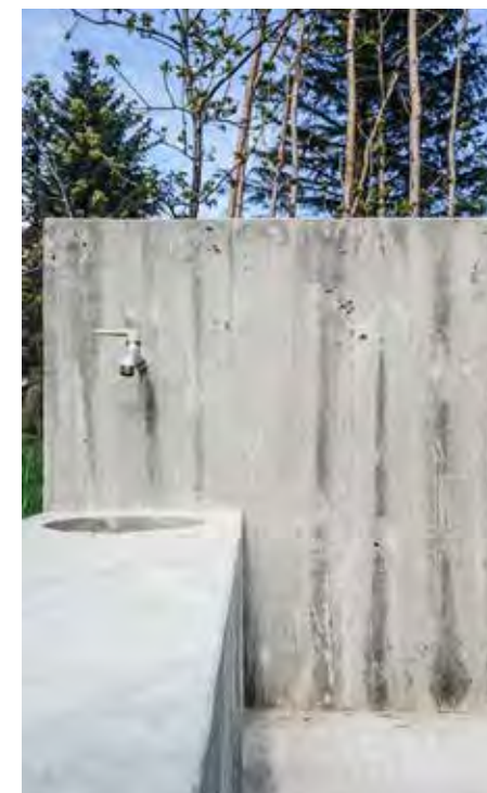
Terrassen mod øst har in situ-støbte mure og gulv. Vandpost og kar er støbt med ind
