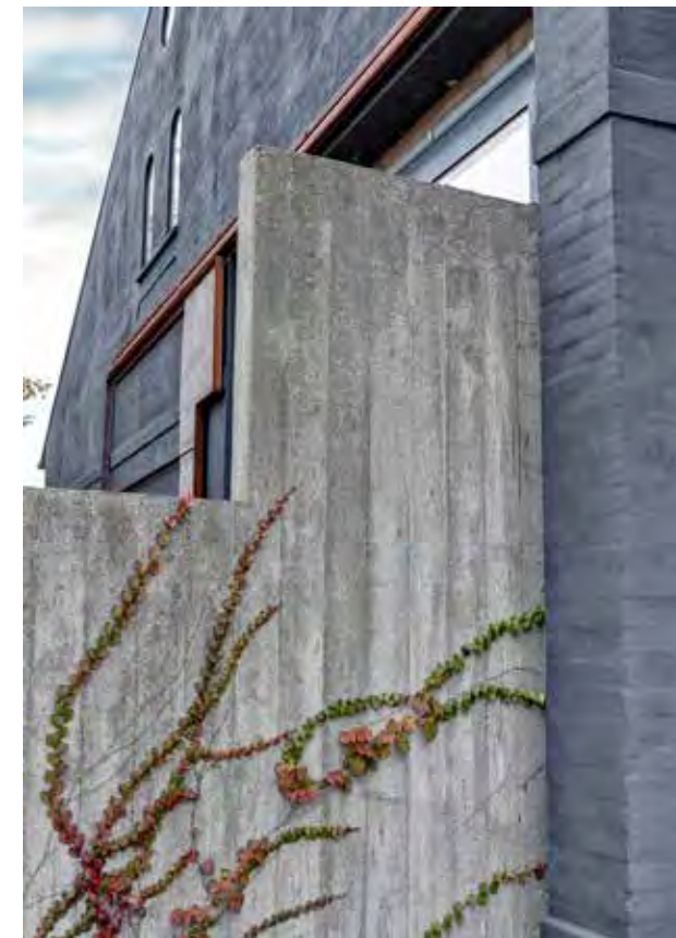
In situ-støbt beton møder det gamle fildsedte murværk og bevokses med årene med vildvin
