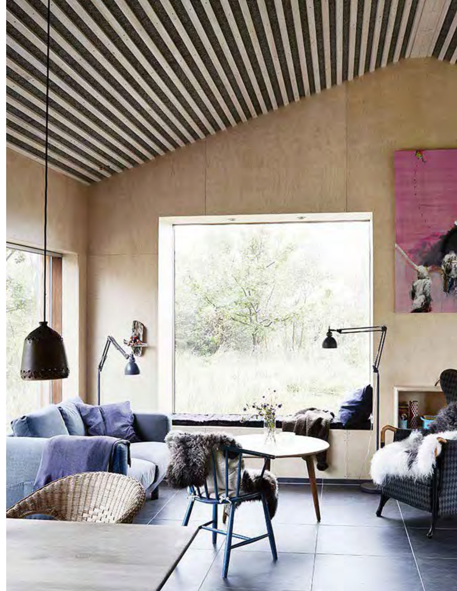
Birkekrydsfiner på vægge og i alkovenichen, gråsorte keramiske fliser på gulv, fyrretræslister på træbeton i loft og vinduesrammer i maghoni
