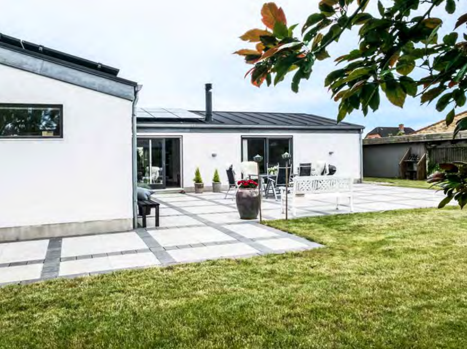
Villaen efter ombygning/tilbygning med tilføjet længe – kig fra syd
