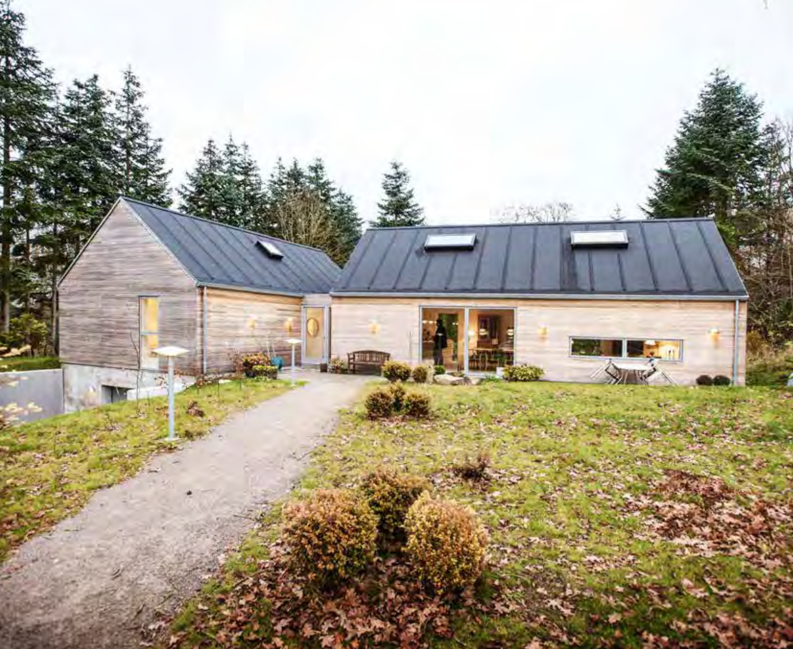
Vestfacade og ankomst – med nedkørsel til garage til venstre
