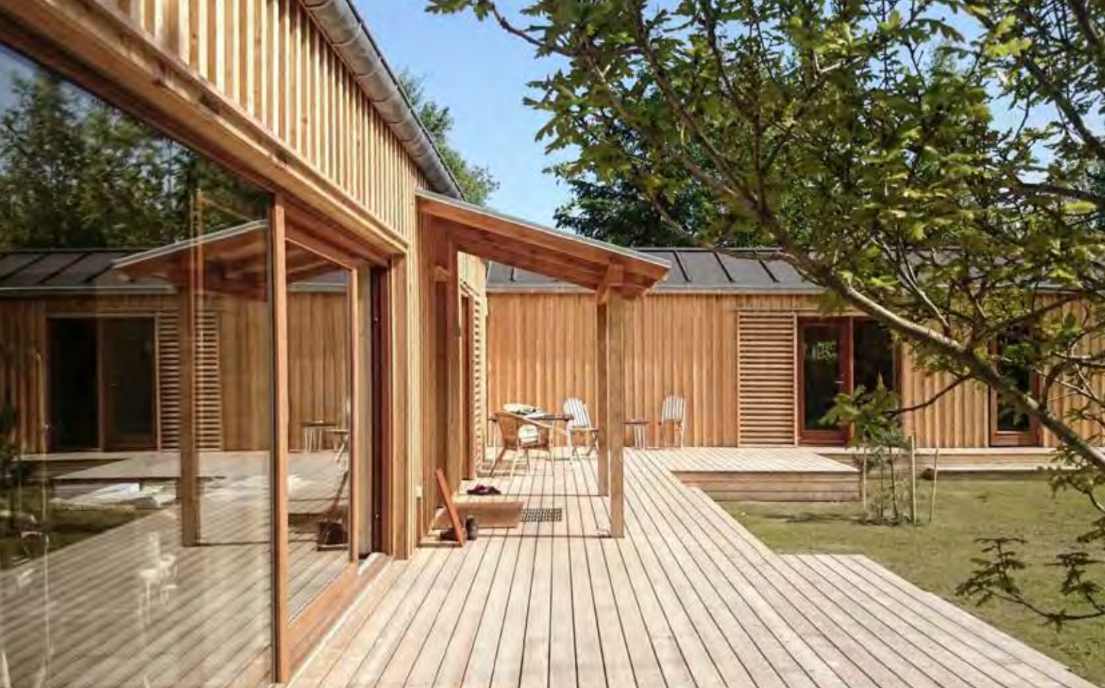
Lærketræ er anvendt både på lodrette og vandrette flader. Skodder er ligeledes udført i lærketræ, og vinduesrammer er i mahogni
