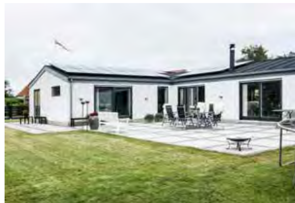
Villaen efter ombygning/tilbygning med tilføjet længe – kig fra sydvest
